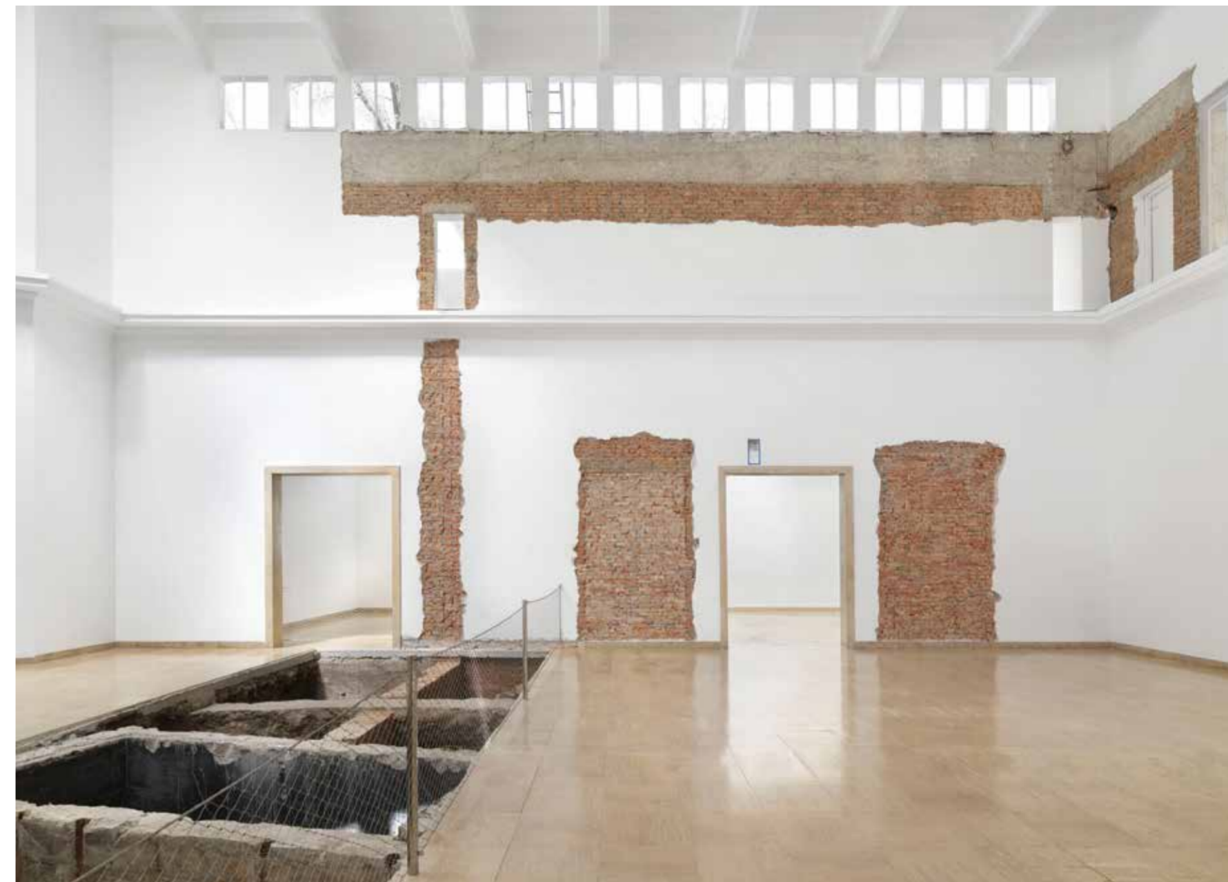
Maria Eichhorn: Premiestnenie konštrukcie . Nemecký pavilón 2022, detail: Základy zadnej steny z roku 1909; spoj medzi časťami budovy z rokov 1909 a 1938; zadná stena budovy z roku 1909, vnútorná stena z roku 1938, zburaná v roku 1964; nápisy na stene; vchod do pravej bočnej miestnosti z roku 1909, zamurovaný v roku 1912; výskum omietkových vrstiev; vchod do pravej bočnej miestnosti z roku 1909, zamurovaný v roku 1912, znovu otvorený v roku 1928, zamurovaný v roku 1938, pohľad na výstavu © Maria Eichhorn / VG Bild-Kunst, Bonn 2022, foto: Jens Ziehe
